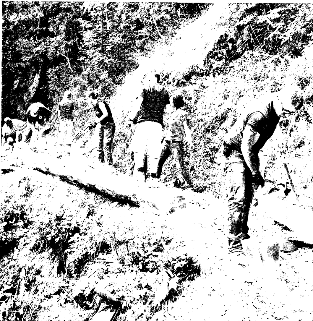
Unterhaltsarbeiten. Sicherung einer abgerutschten Stelle durch die Gruppe Romeo Hutter. FOTO ZVG
