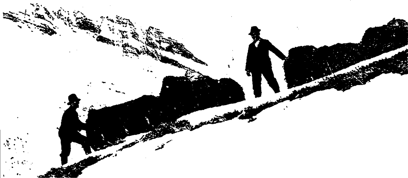
«Höüzier» bim Hewwtransport: e schweeri Aarbeits!
