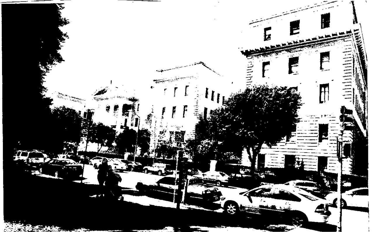
Ausgebaut. Von Gustav Erpen saniertes, sich im Klosterbesitz befindendes Palast mit Sozialwohnungen, San Francisco.
